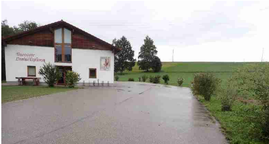
Abbildung 58: Blick auf das Feuerwehrhaus und dessen Einfahrt
