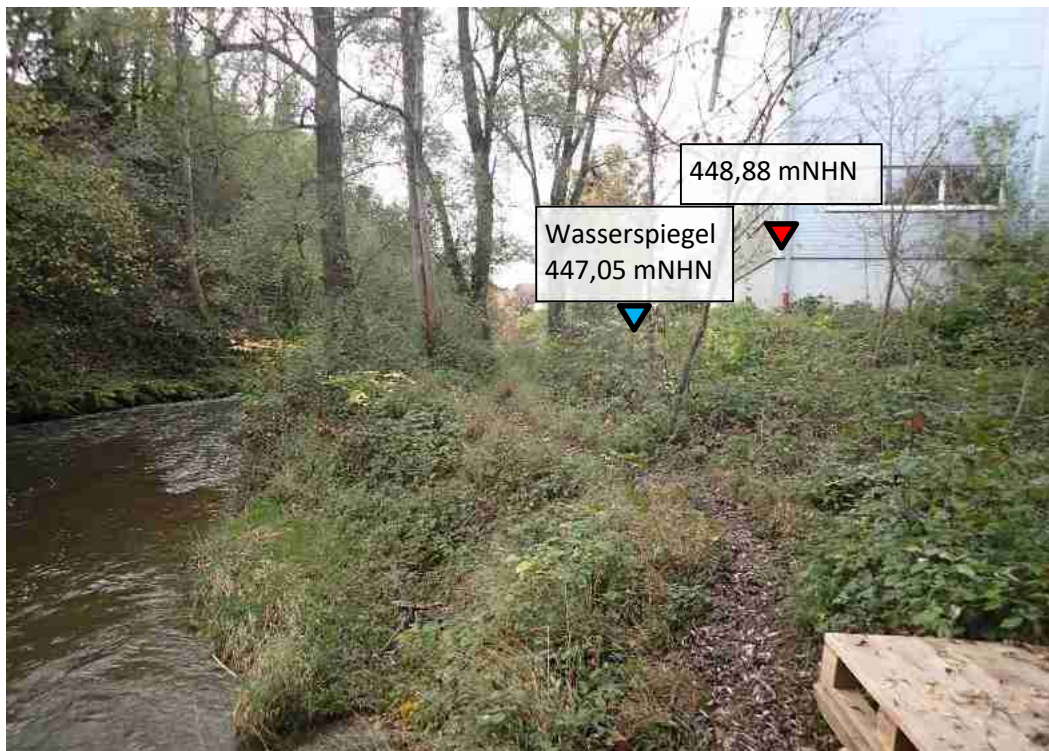
Abbildung 54: Südseite des Gebäudes Hofmühlstraße 32
