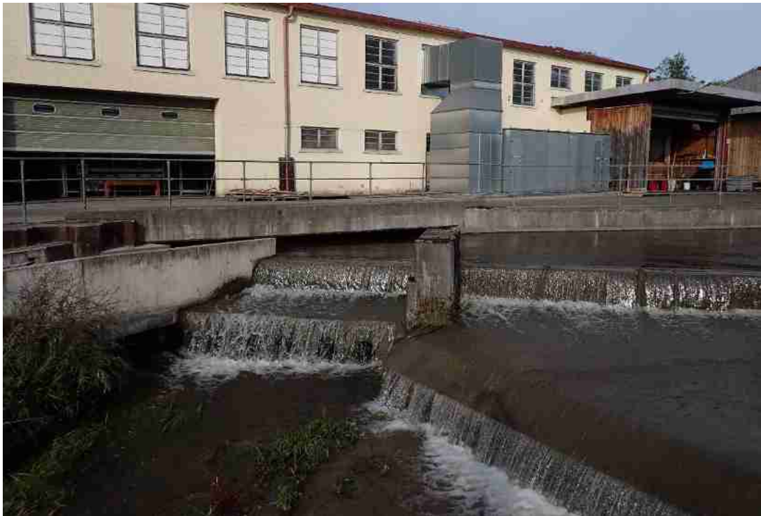
Abbildung 21: Blick von unterstrom auf die Stauanlage „Landl“
