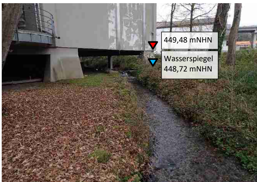
Abbildung 52: Gebäude in der Hofmühlstraße 34 mit Blick auf den Wäschebach
