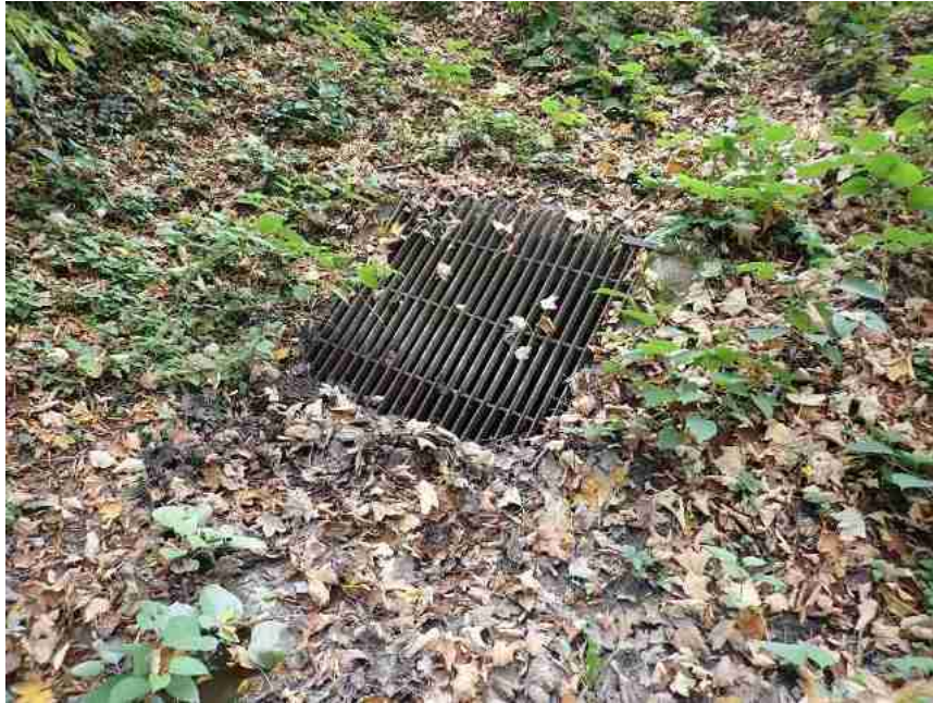
Abbildung 31: Einlaufbauwerk beim Hammererweg nördlich der Bahnlinie
