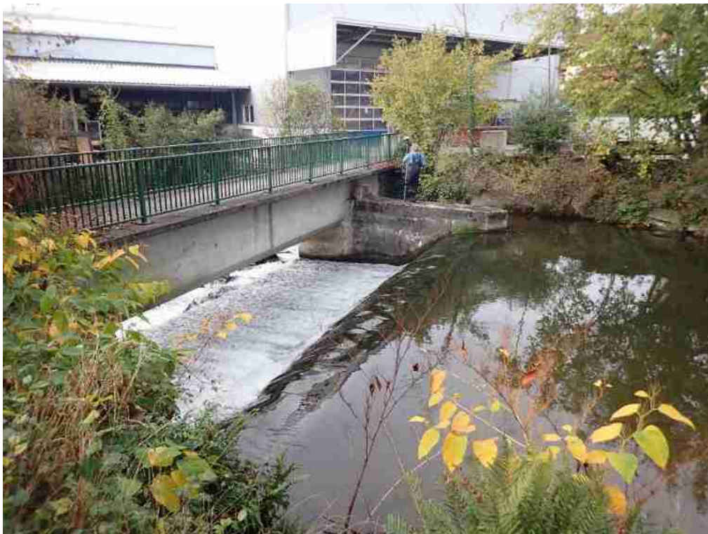
Abbildung 24: Stauanlage Höhe „Hofmühlstraße 32“
