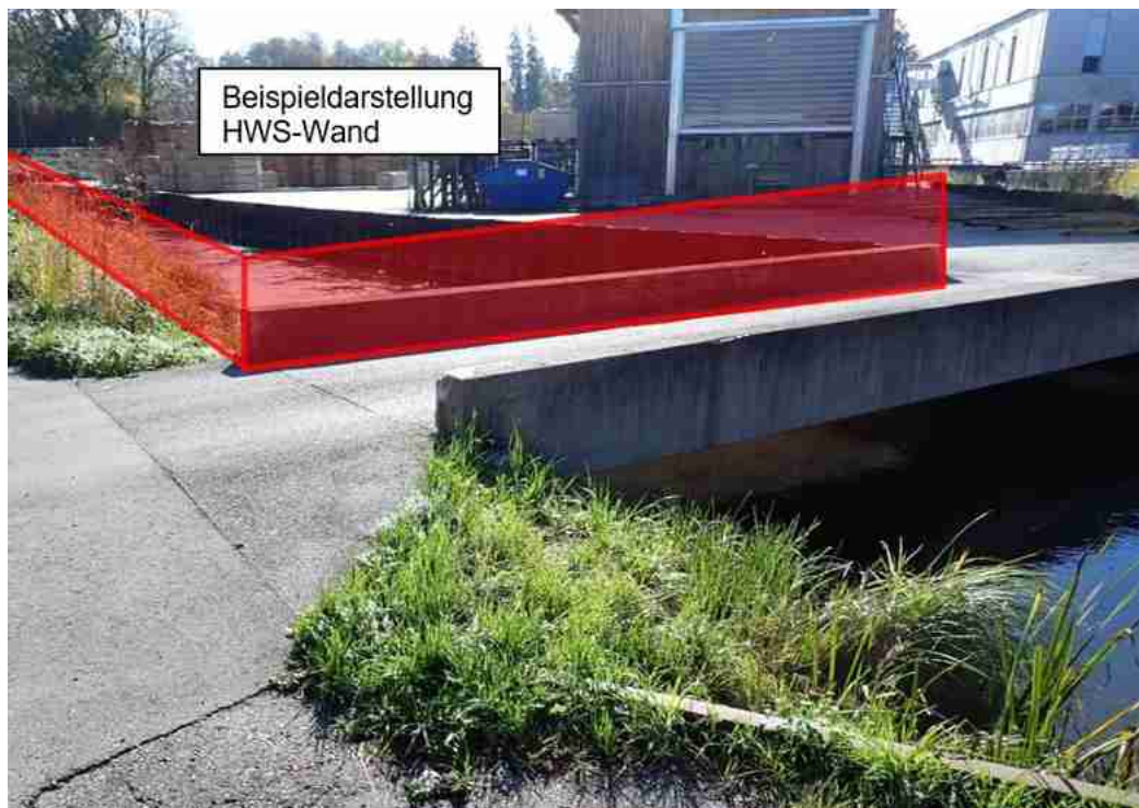
Abbildung 50: Brücke im Osten des Gewerbegebiets
