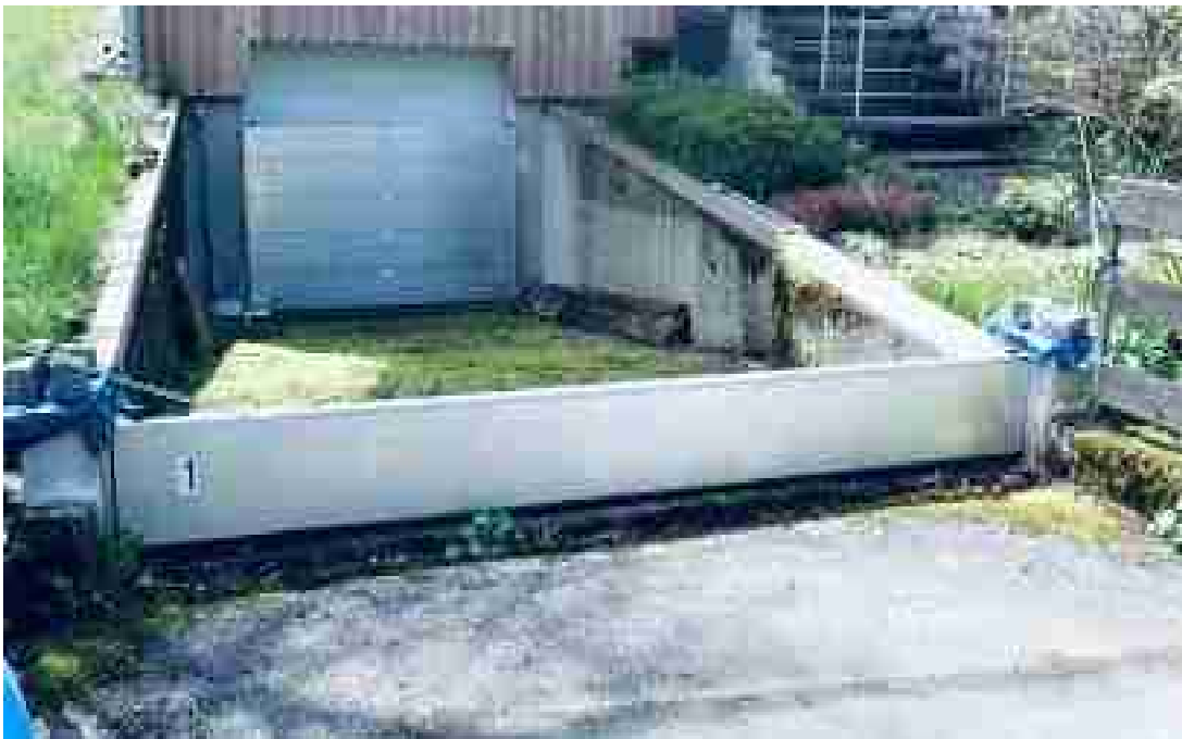
Abbildung 68: Hochwasserangepasste Bauweise einer Garage
