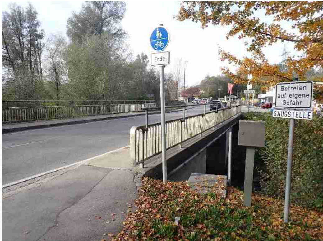
Abbildung 56: Brücke Rohrdorfer Straße über die Sims
